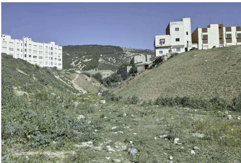
Figura 7 | Fès, zona “Oued”: l’edificazione in prossimità di aree ad alta pericolosità idraulica comporta rischi notevoli, specie in un quadro di esasperazione dei fenomeni ambientali dovuta ai cambiamenti climatici.
