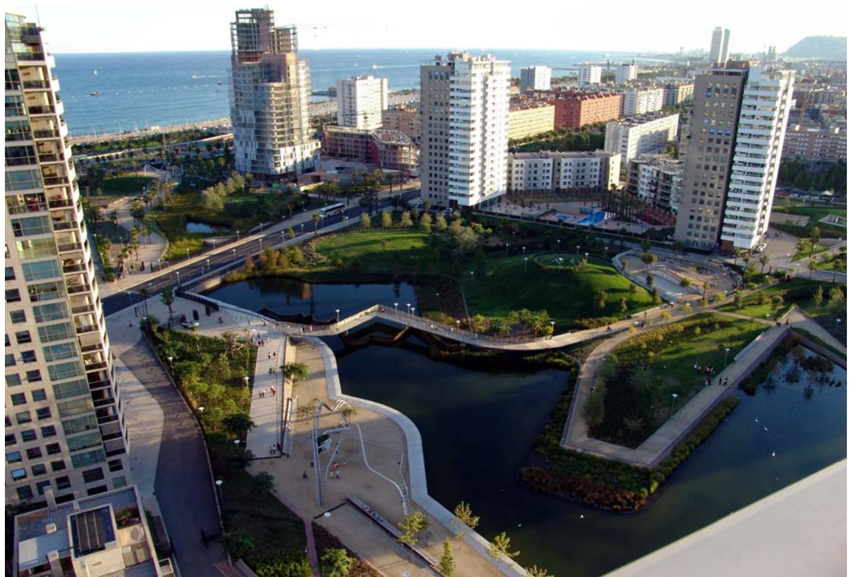
Fig. 5: l'attenzione agli elementi compositivi del parco urbano (progetto dello studio Miralles-Tagliabue) alla Diagonal-Mar.
