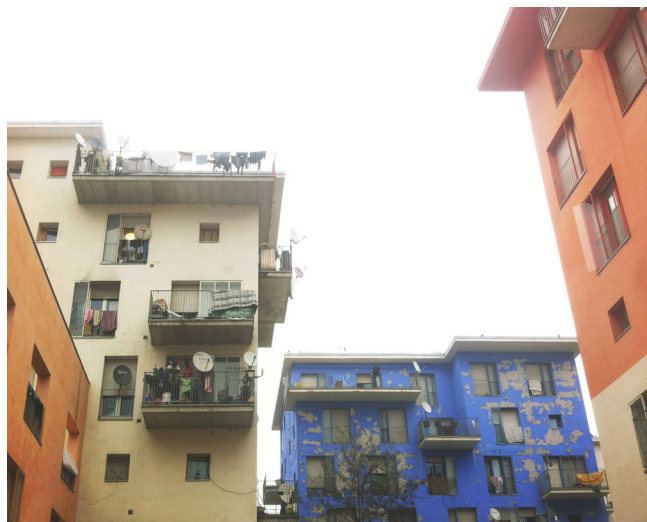
Figura 3 | ExMoi: gli edifici occupati e gli appartamenti. Fonte: elaborazione dell'autore.
