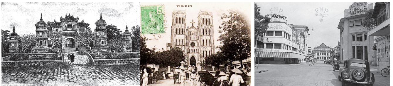
19 | La Bao An pagoda demolita per lasciare spazio alla chiesa di S.Giuseppe, una versione tropicale di Notre Dame de Paris
