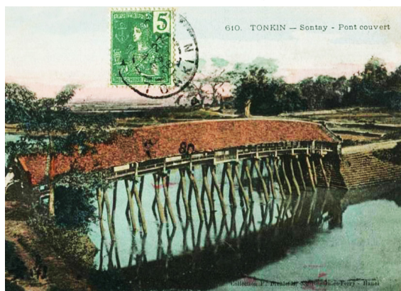
6 | Il ponte coperto di Son Tay meraviglioso esempio di architettura del paesaggio
