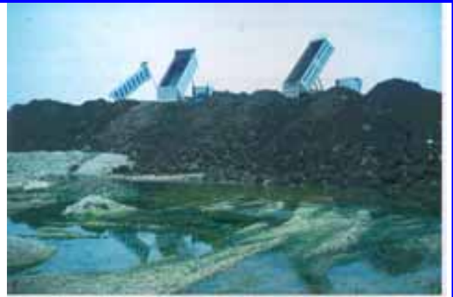
Riporto terra per riprofilatura scarpata
