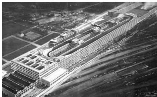
Fig. 4. Sopra, l'immagine di Roadtown, sotto l'edificio della Fiat Lingotto a Torino, con la pista per il collaudo della auto sul tetto
