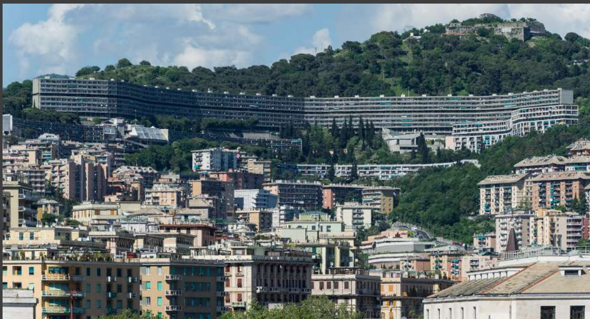
In alto un'immagine zenitale del quartiere di Forte Quezzi, in basso l'imponente mole dell'edificio segna il paesaggio delle colline al di sopra del centro urbano.
