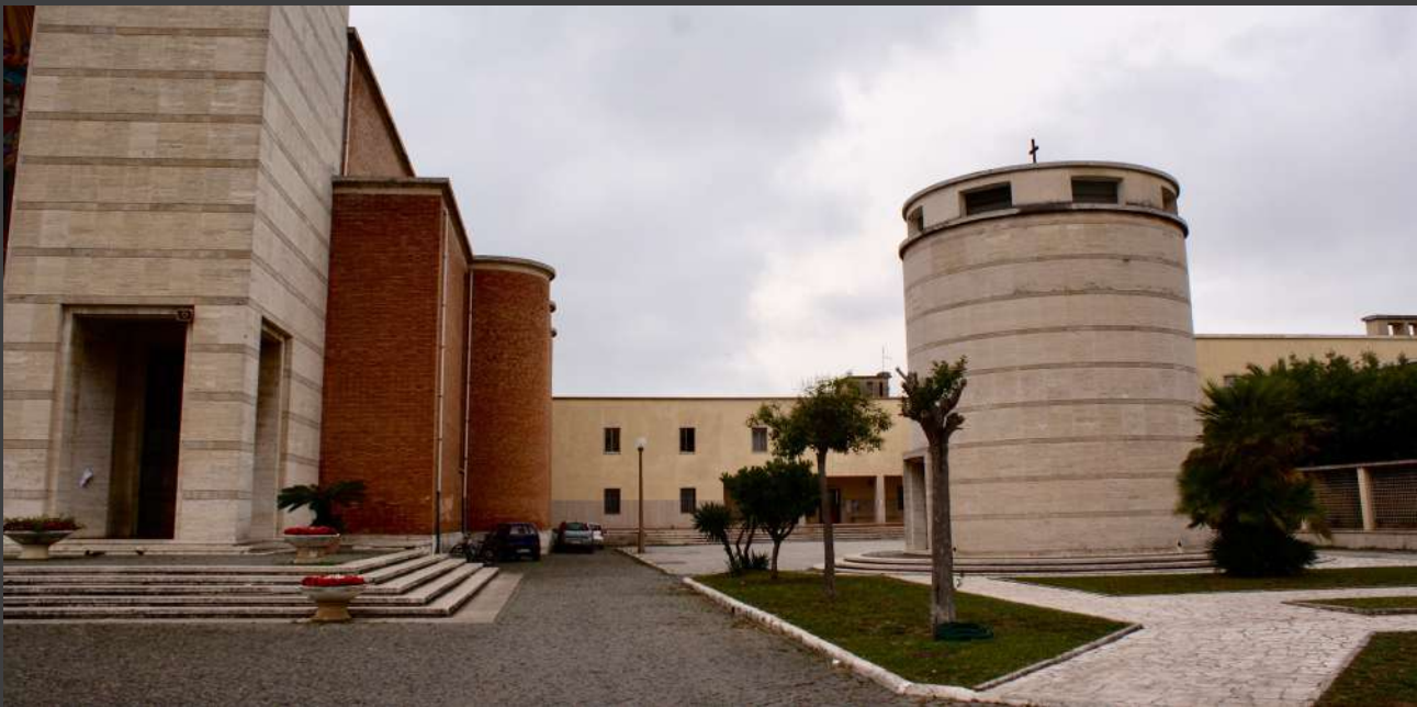
Di fronte alla piazza del municipio è ricavato un ampio spazio sistemato a giardino con al centro una fontana. Sotto, lo spazio pubblico realizzato alle spalle della cattedrale.
