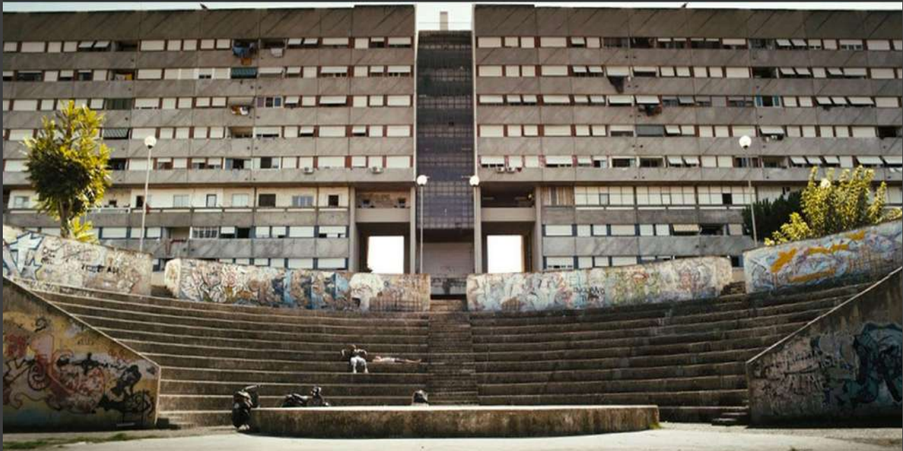
Un'immagine della parte terminale del grande edificio dalla quale si nota chiaramente la contrapposizione di due edifici diversi, separati da un ballatoio. In basso, l'anfiteatro ricavato nello spazio esterno, uno dei pochi spazi pubblici realizzati fra i numerosi previsti e la cui realizzazione è alla base del progetto di rigenerazione in corso
