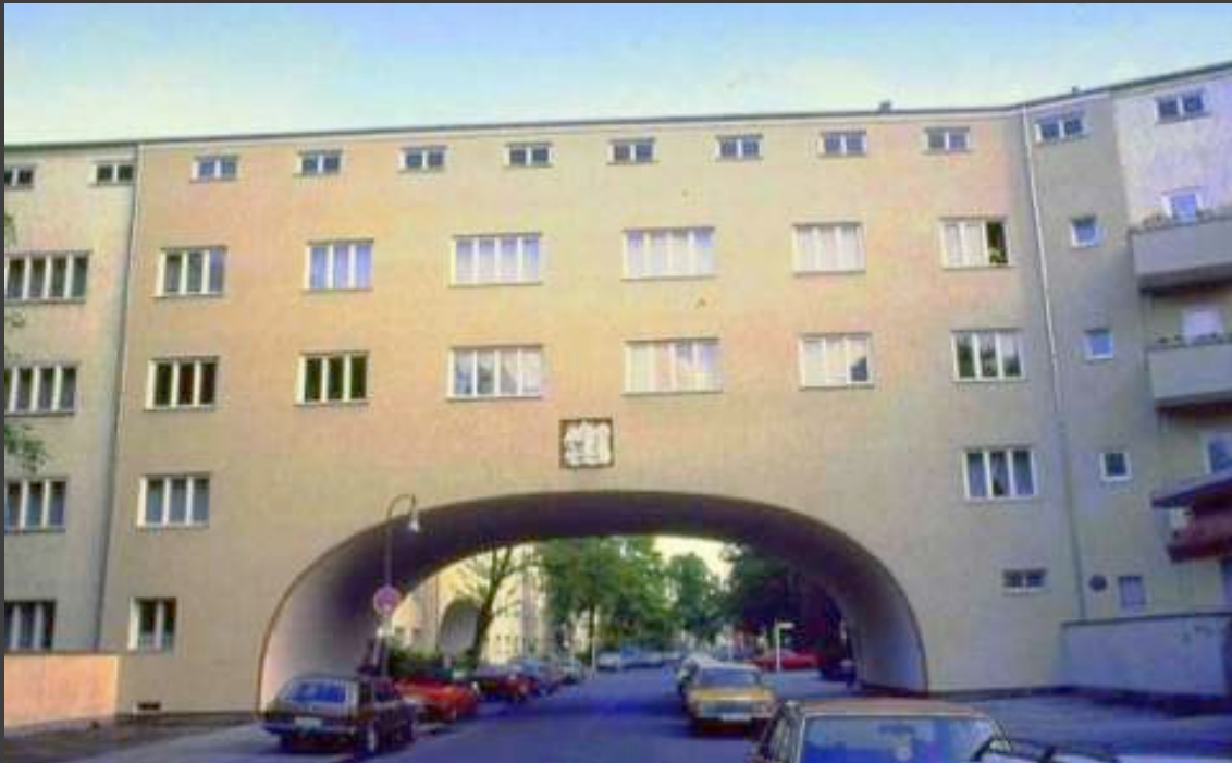
Sopra, un lungo fabbricato continuo delimita un lato dell'intero quartiere. Sotto un'immagine dell'edificio progettato da Hans Schoarunche funge anche da "porta di accesso" del quartiere, scavalcando con un grande arco, la strada carrabile.
