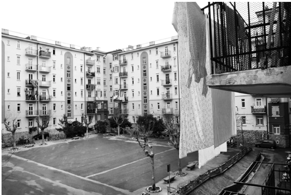
Figura 2 | Il Vaticano, vista interna alla corte. (Fonte: arch. Gianna Omenetto)
