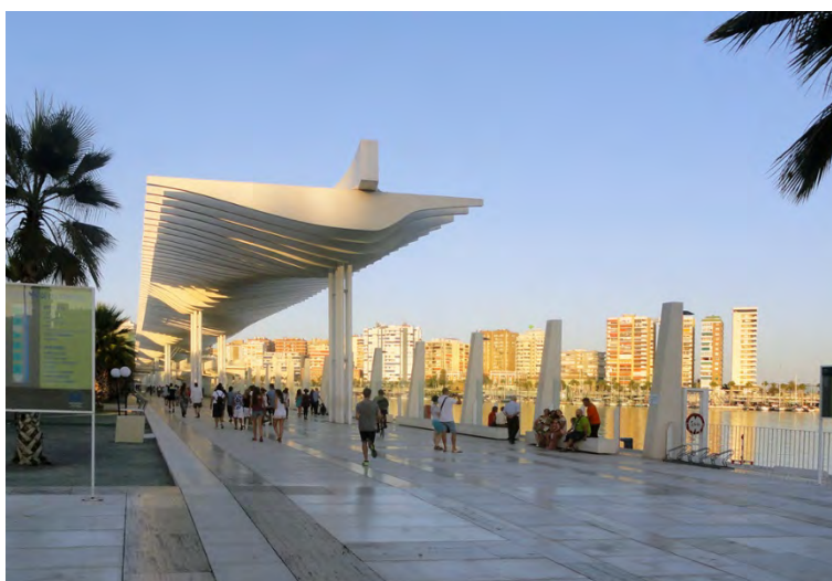
Figura 3 | Riqualificazione area portuale di Malaga. Fonte: fotografia degli Autori.
