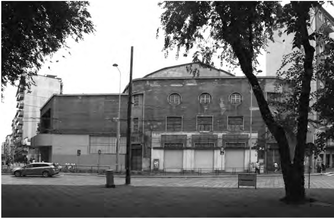
Figura 2 | Tasselli di degrado, l'ex cinema Maestoso a Milano
