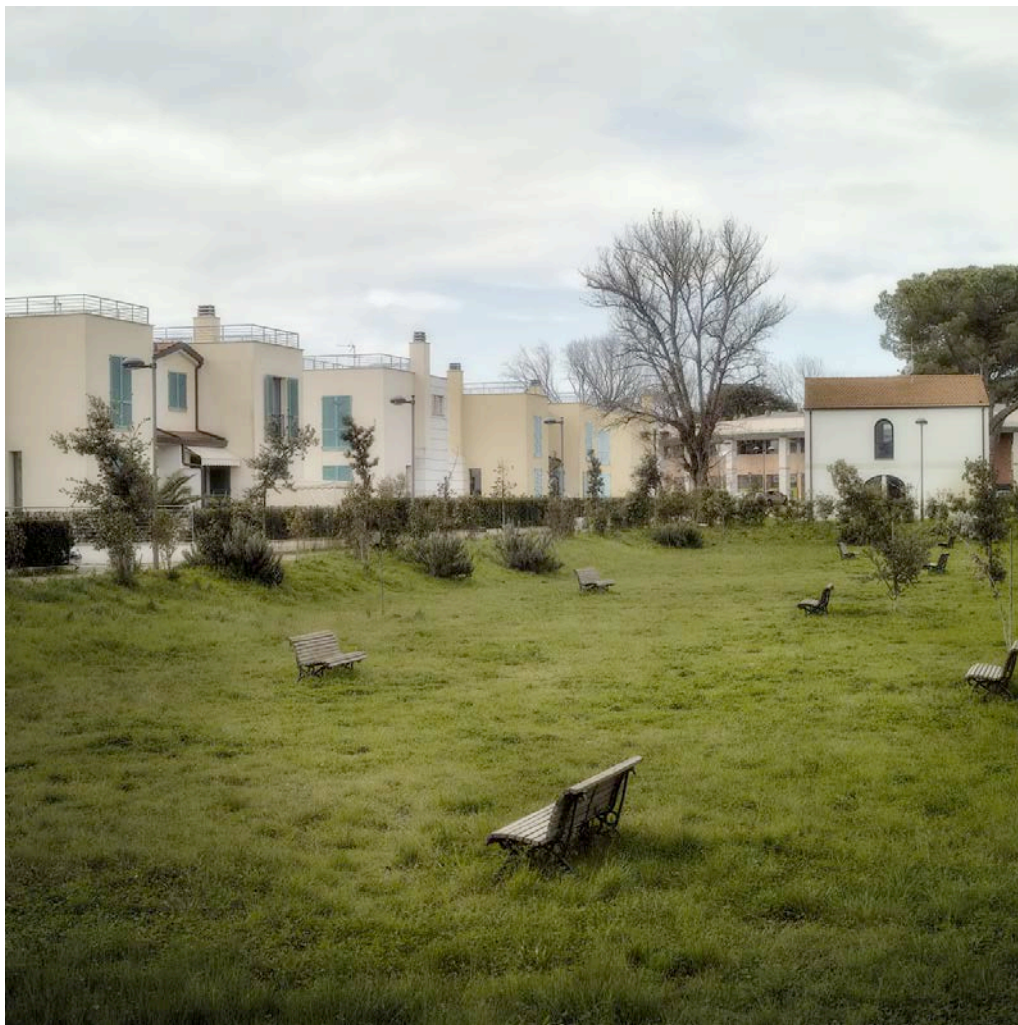
Figura 5 | L'interruzione del cantiere dello spazio pubblico. Versilia. Foto di Fabio Lucchesi
