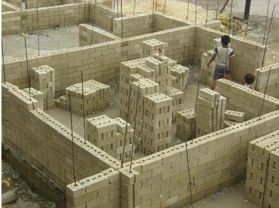
Figura 2 | Un momento del cantiere a Mandaue mediante l'utilizzo dei blocchi ICEB.
