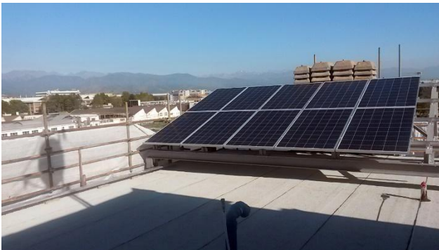
Figura 7 Vista delle coperture, dopo dell'intervento. Fonte: Architettura senza Frontiere Piemonte.
