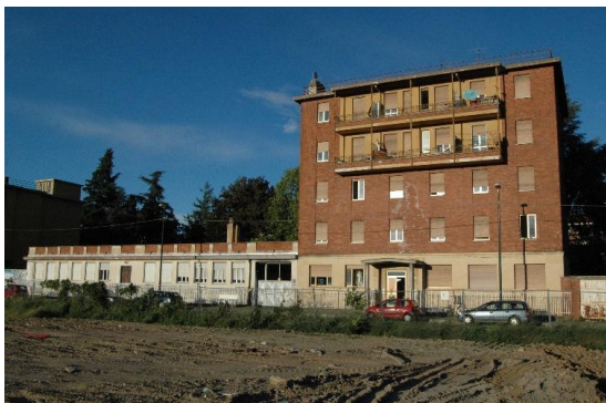
Figura 1 Vista dell'immobile da via Madonna de la Salette, prima dell'intervento. Fonte: Architettura senza Frontiere Piemonte .
