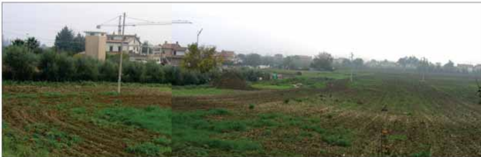
vista dell'area di intervento
