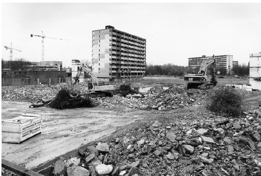
Figura 3 | Demolizione dei blocchi di Bijlmermeer, 1998. Fonte: Bijlmermuseum.
