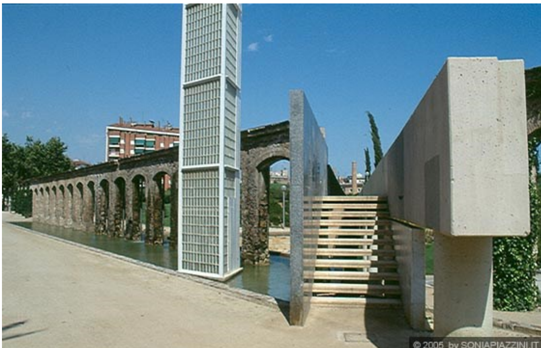
Figura 2. Scala di accesso al percorso sopraelevato che attraversa la piazza - giardino e lo specchio d'acqua ai piedi delle arcate del Parco Del Clot
