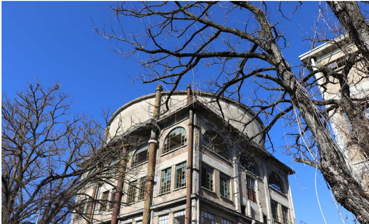
Figura 2 | Il palazzo-serbatoio: sotto la cisterna sono collocati i locali dell'ufficio tecnico dove sono stati ritrovati gli elaborati progettuali originali dell'impianto, oggi conservati presso l'Archivio di Stato. Ex SNIA Viscosa, Rieti, febbraio 2018. Fonte: foto dell'autore.
