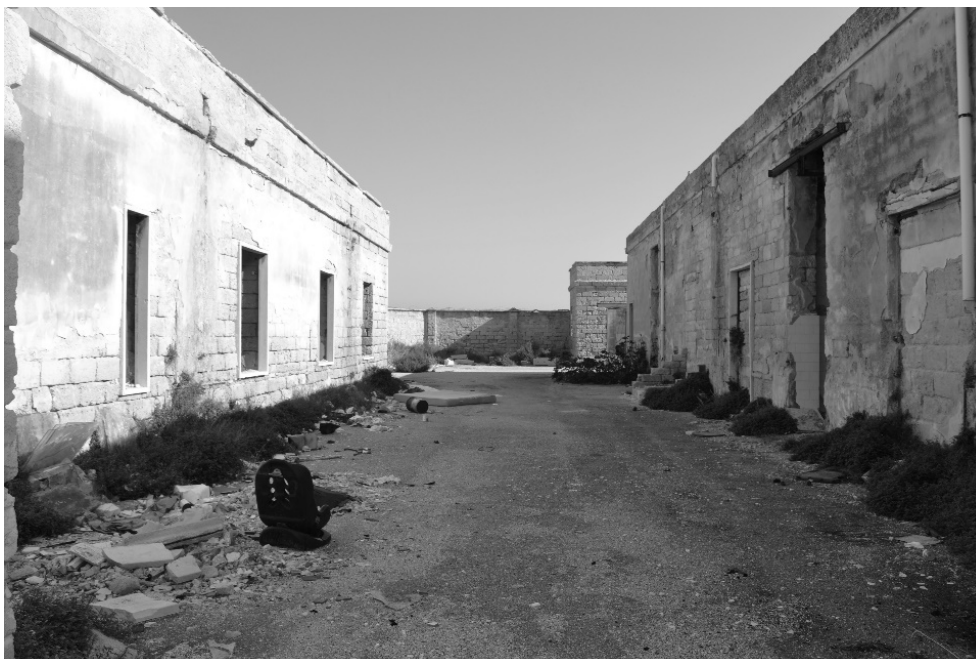
Figura 2 | Condizioni di degrado degli spazi interni dell'edificio. Fonte: immagine scattata sul luogo.
