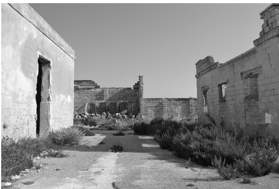
Figura 3 | Condizioni di degrado statico dei solai degli edifici. Fonte: immagine scattata sul luogo.
