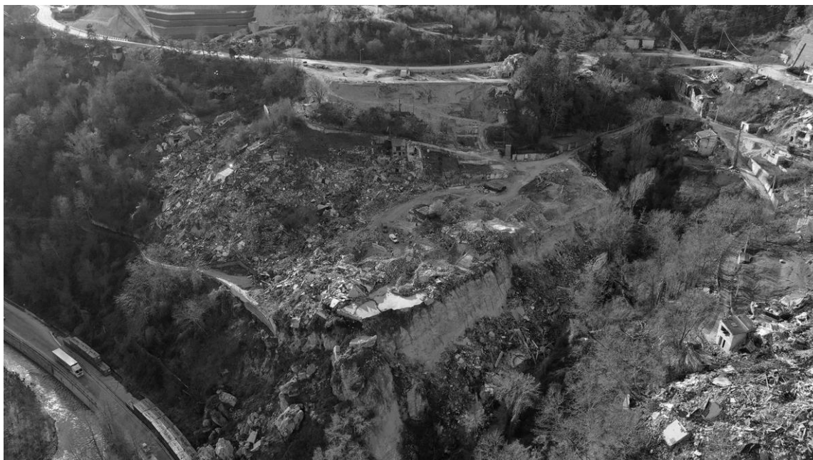
Figura 2 | Pescara del Tronto, 2016, dopo il secondo sisma
