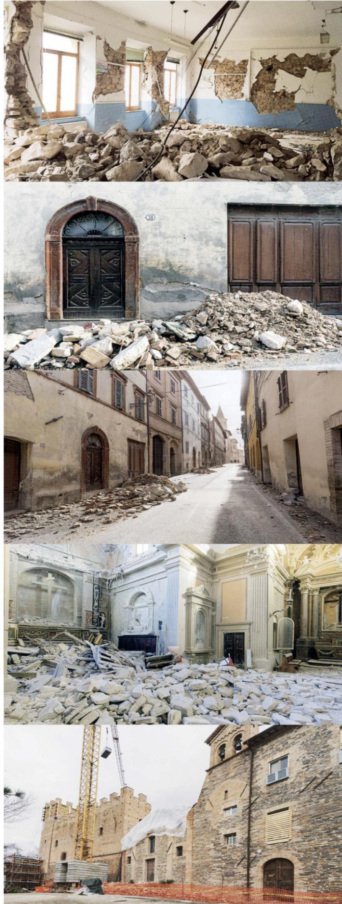
Figura 1 | Regione Marche, Provincia di Macerata, Comune di Caldara. Danni del sisma dopo la seconda scossa, ottobre 2016
