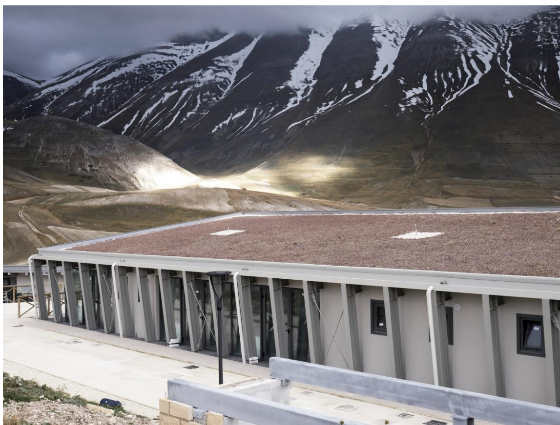
Figura 4 | Il Deltaplano, foto dal cantiere, autunno 2018 Fonte: foto di Alexandra D'Angelo
