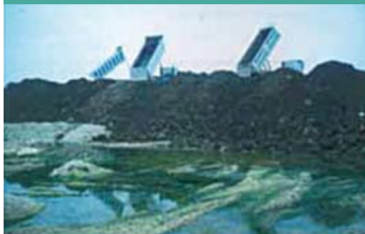
Riporto terra per riprofilatura scarpata
