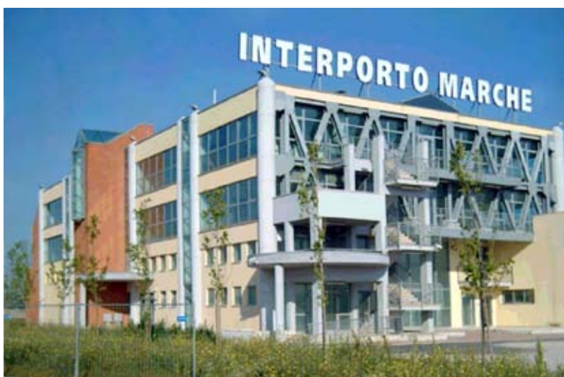
Centro Direzionale dell'Interporto Marche (fonte Società Interporto)
