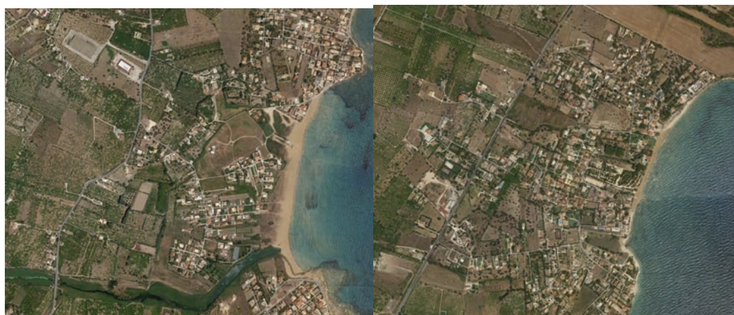
Figura 2 | Avola Insediamenti costieri in aree ad elevato rischio idraulico.
